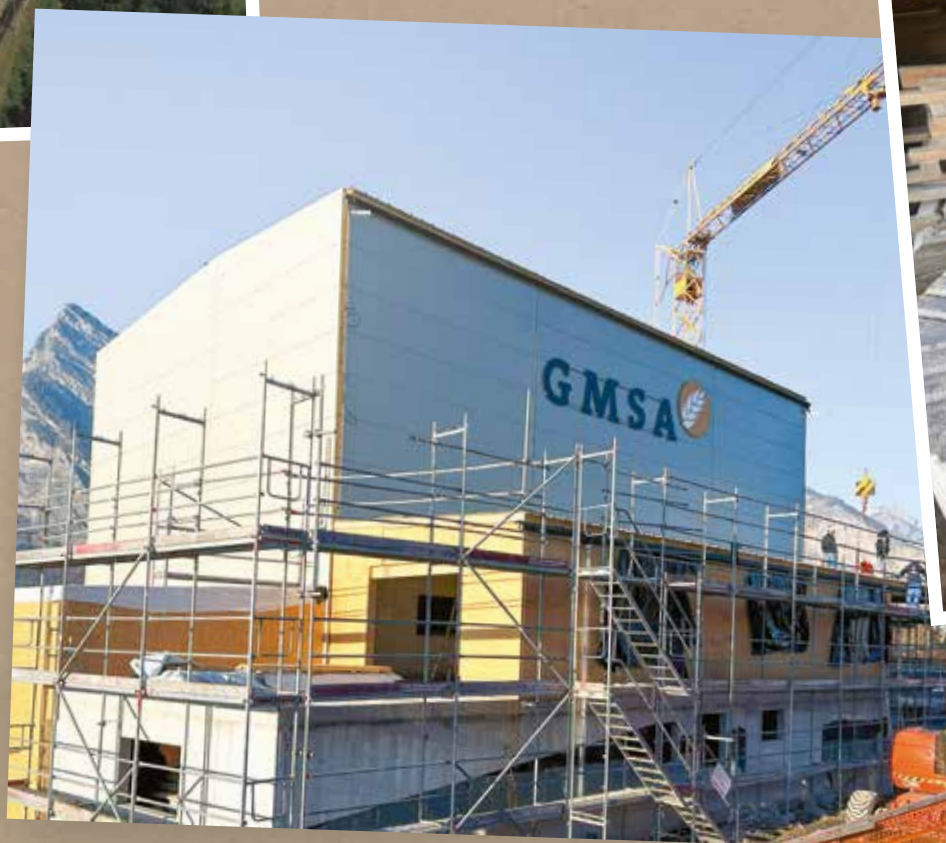
Die neue Mühle von Riddes/VS im Bau
